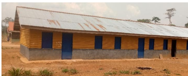
Figure 33 Maison des travailleurs d'IFCO
