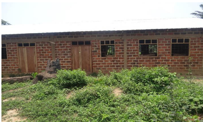
Figure 17EP. Lomata en construction à Kalanga
